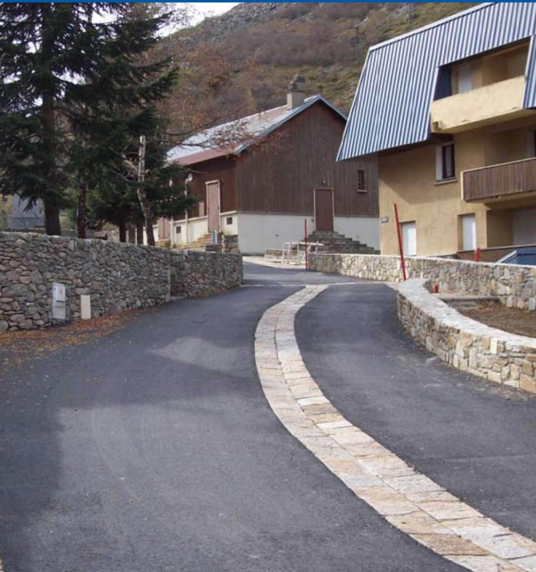
L'aménagement de la rue «Cimetière - Cité des Douanes»
